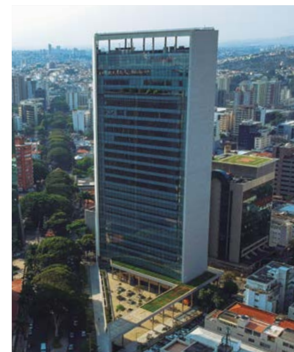
Edifício Aureliano Chaves, de propriedade da Forluz
