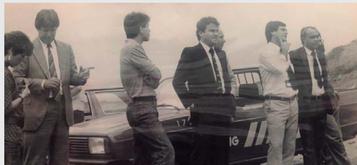
Em inspeção de obra da Gasmig, em 1987
