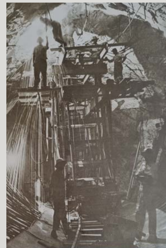
Construção da Hidrelétrica de Salto Grande, na década de 50
